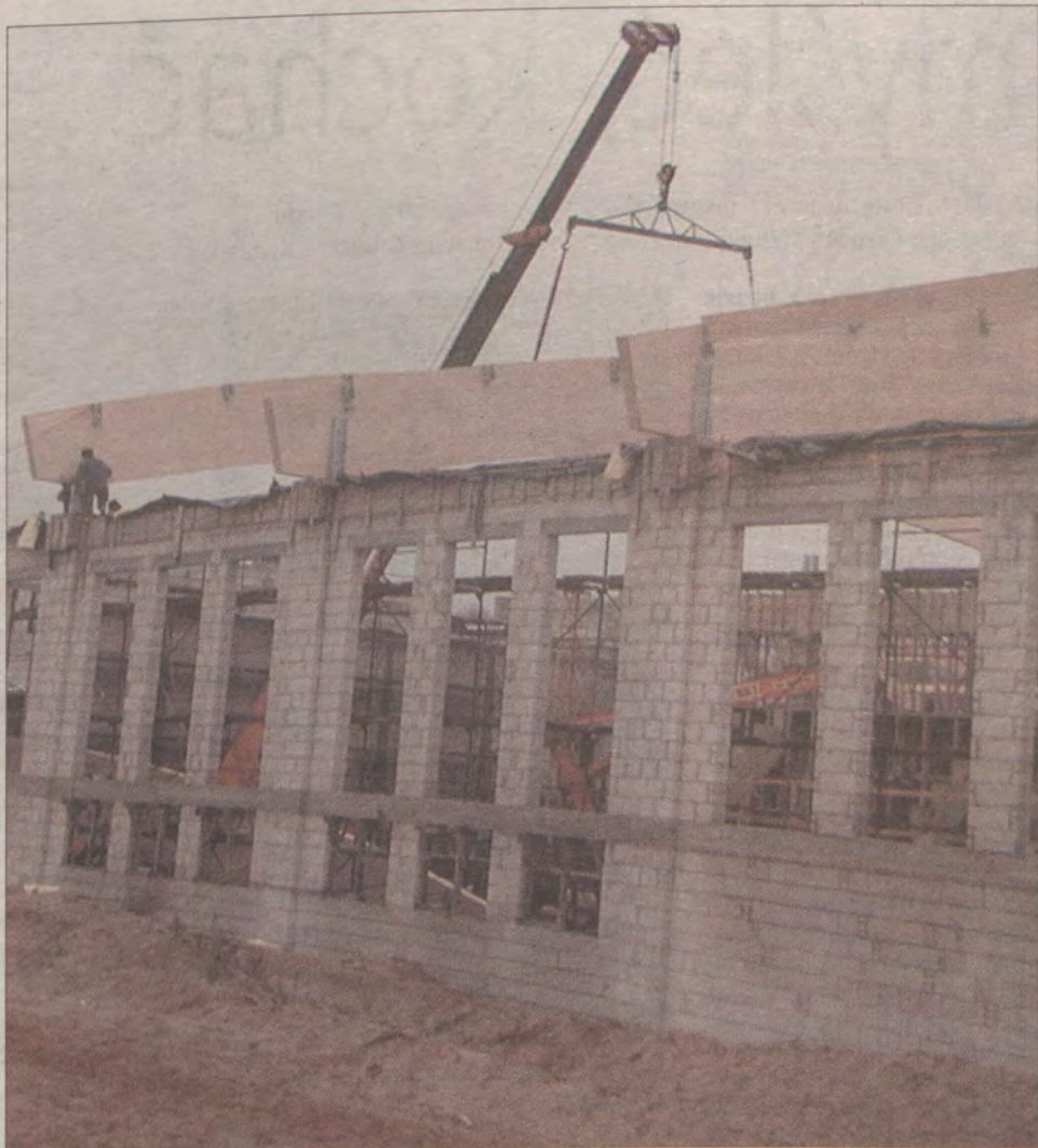
Nad nową salą gimnastyczną stawiane są olbrzymie dźwigary.
