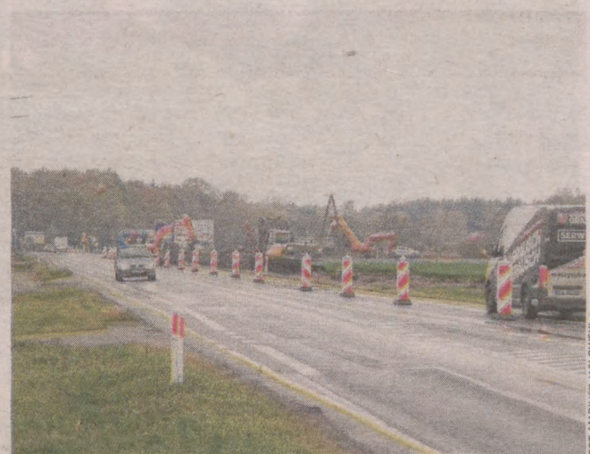
W Grabnie pod Ustką na przebudowie DK21 rozpoczyna się budowa ronda. To pierwsze utrudnienia w ruchu
