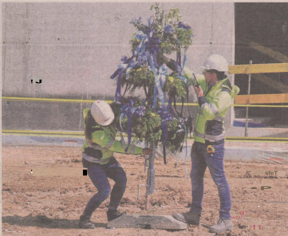
Wiecha, czyli znak zakończenia ważnego etapu budowy, już widoczna. Na ten moment z utęsknieniem czeka wielu inwestorów. Bo zwiastuje koniec wydatków, no i perypetii
