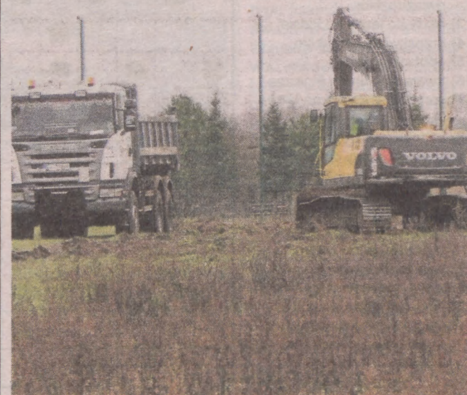
W Ustce jest budowane boisko treningowe
