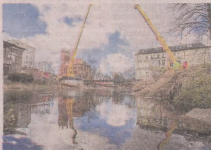
9 marca rozpoczął się montaż największej kładki nad Słupią
