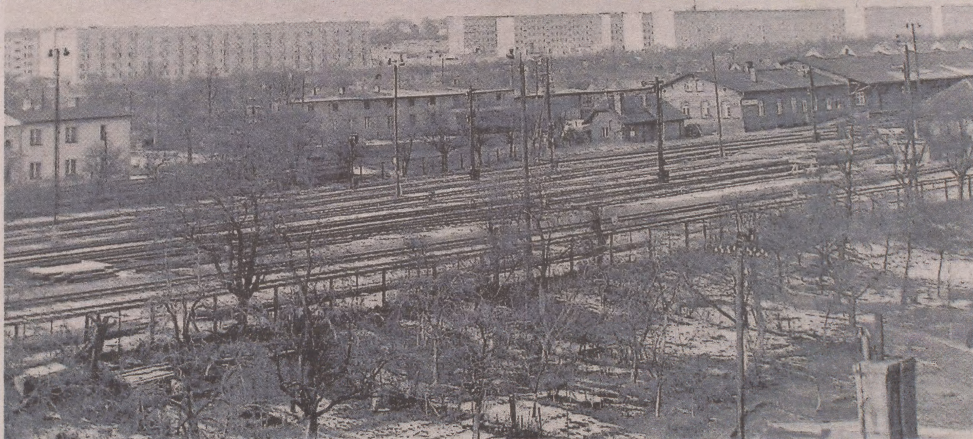
Rok 1973, panorama Zatorza z ulicą Sobieskiego wzdłuż linii kolejowej, widziana z okna na strychu kamienicy nr 41 przy ul. Kołłątaja
