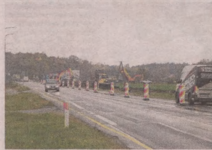
W listopadzie rozpoczęła się przebudowa drogi Słupsk - Ustka
