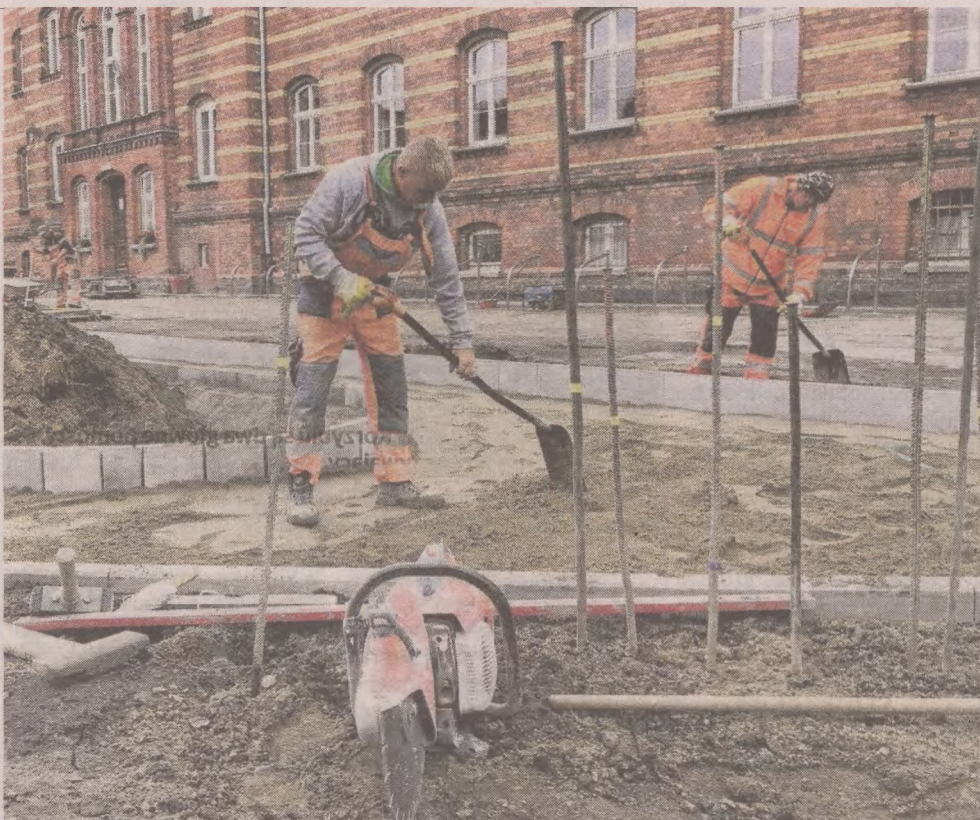
W ramach przygotowań do nadchodzącego roku szkolnego szkoły i placówki oświatowe ze Słupska i regionu przeprowadzają wymagane remonty i inwestycje. W przypadku Szkoły Podstawowej nr 1 prace objęły poprawę infrastruktury. Koszt prac wyniósł 185 679 złotych
