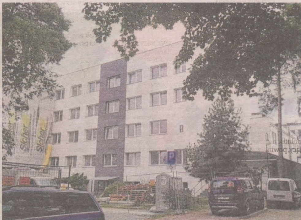
Za kilka miesięcy skończy się w Ustce trwająca już rok duża inwestycja przebudowy szpitala
