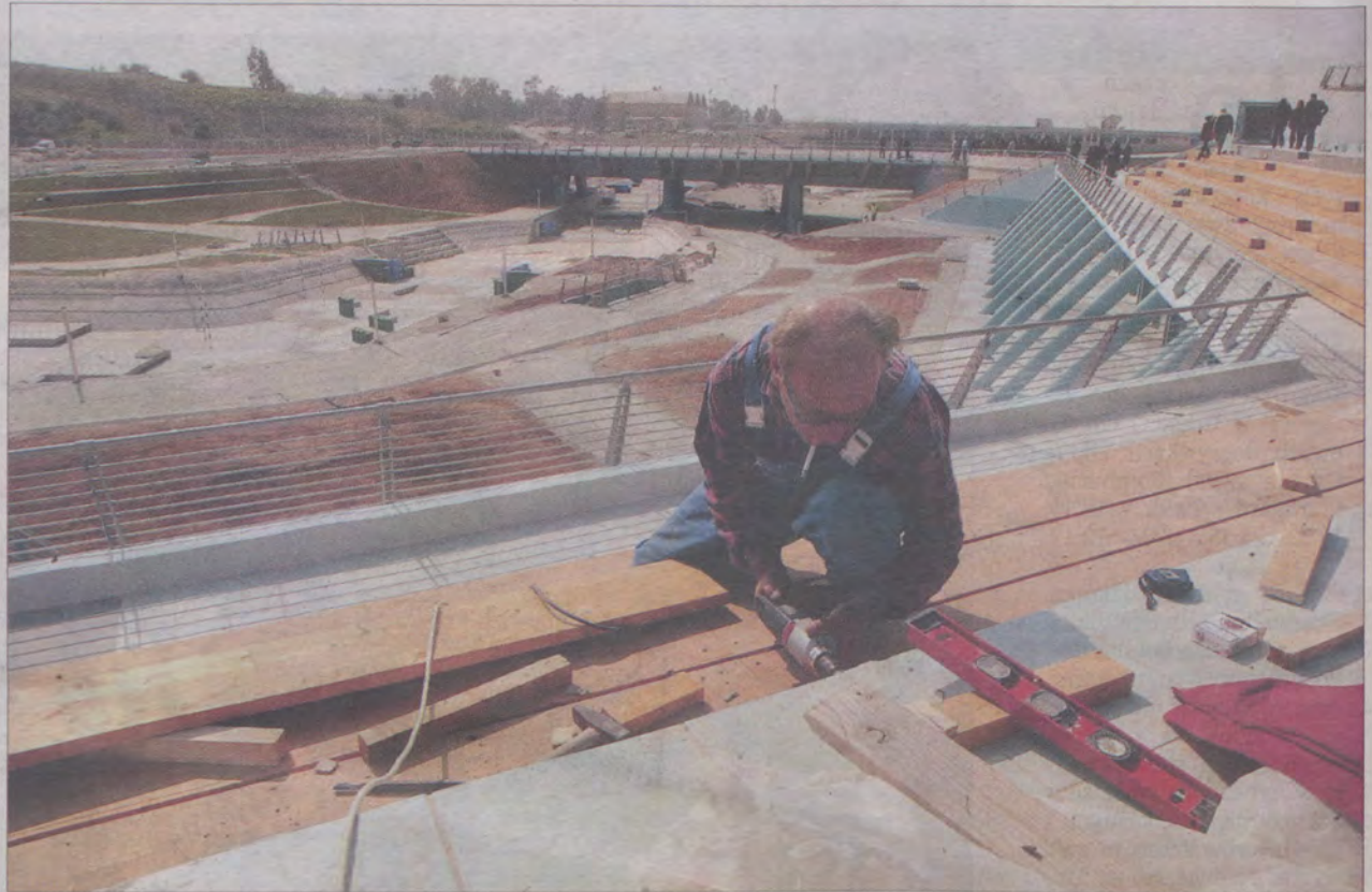
Trwają prace budowlane na Stadionie Olimpijskim w Atenach. Stadion ma być zadaszony.
