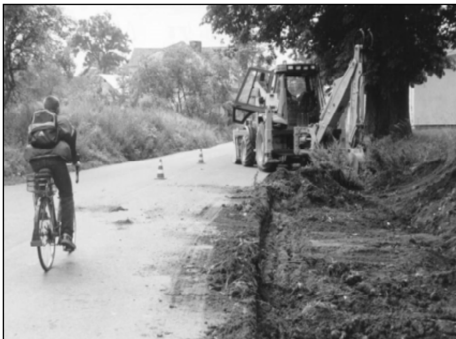
Mieszkańcy Kończewa z własnej inicjatywy rozpoczęli budowę chodnika
