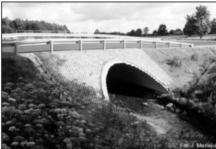
Nowy przepust na drodze powiatowej Sierakowo-Barcino
