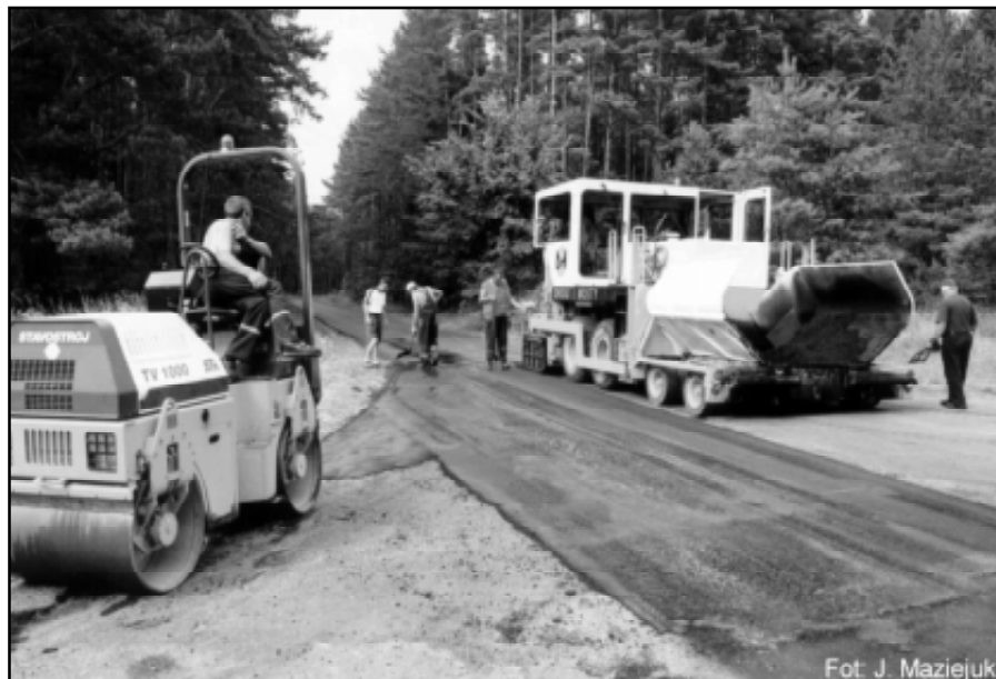
Prace na drodze w Dębnie Kaszubskiej
