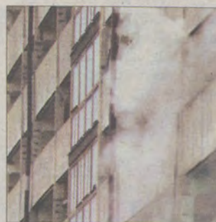
Remont falowca trwa.
