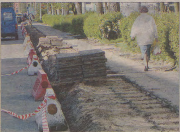
W tym miejscu będzie nowa kolorowa kostka.
