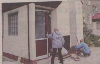
Budowa wiatrołapów przy ul. Unrug 78 wkrótce się skończy.
