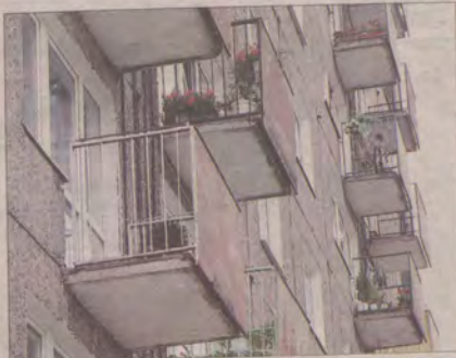
W bloku przy ul. Stolarskiej 21 będzie w tym roku generalny remont.
