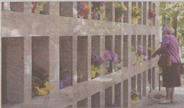
Nowe ściany urnowe, takie, jak na zdjęciu, wykonane zostaną na cmentarzu na Witominie i w Kosakowie.
