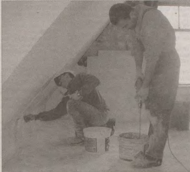
Mieszkańcy Ciechocina remontują świetlicę. Przy pracy Piotr Labe i Karol Sprada.
