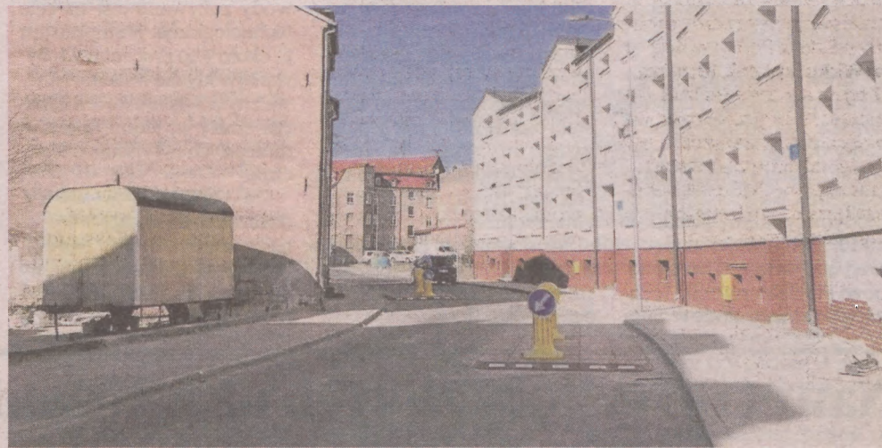
Zamiast kocich łbów asfaltowa nawierzchnia, do tego nowe oświetlenie i przebudowa chodnika
