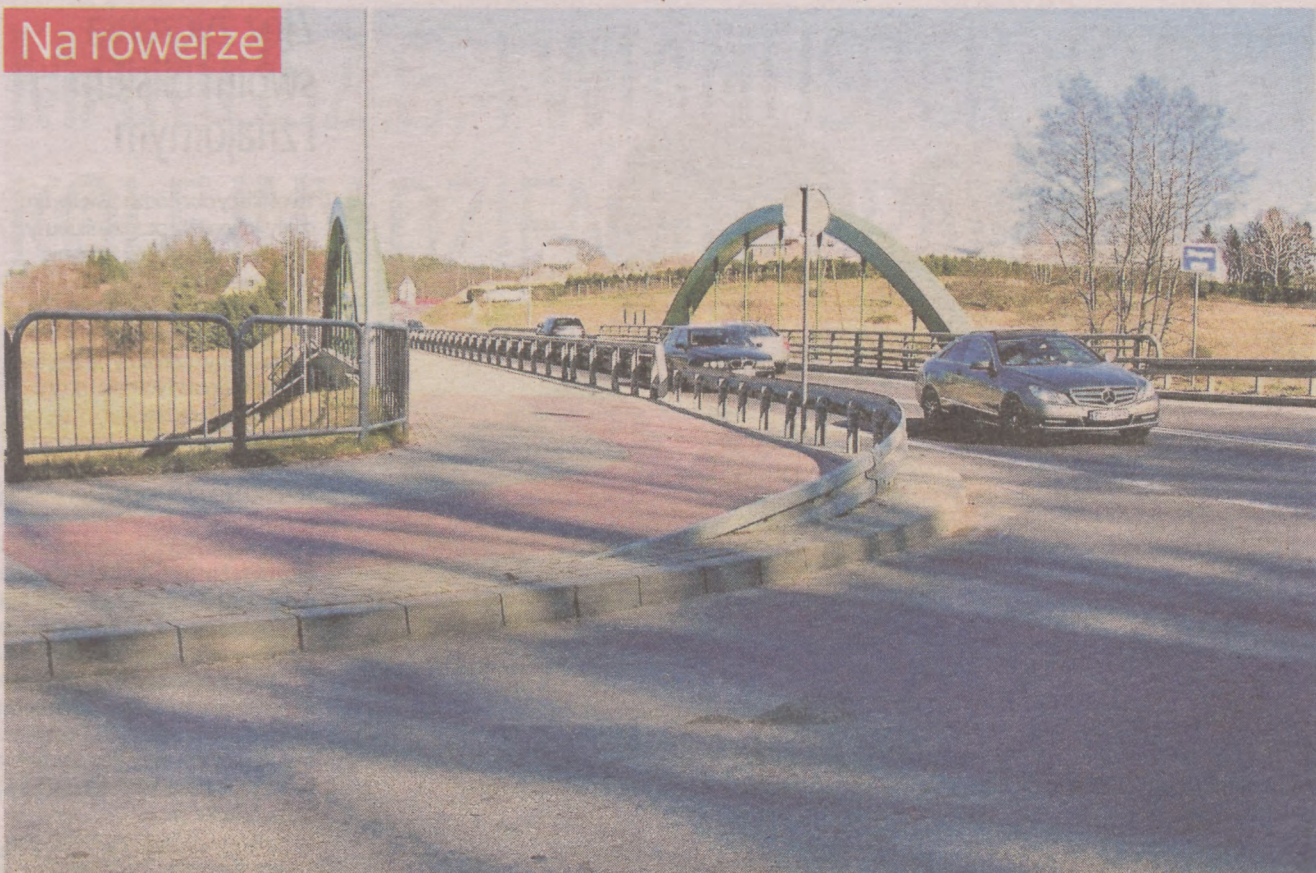
Zbudowany 5 lat temu most na Słupi w Bydlinie, którym przebiega zaledwie 200-metrowa droga pieszo - rowerowa
