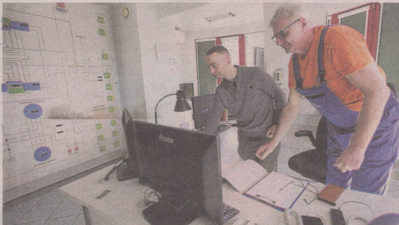
Stacja uzdatniania wody przy ul. B. Westerplatte w Słupsku. Tu dbają o to, co mamy w kranach
