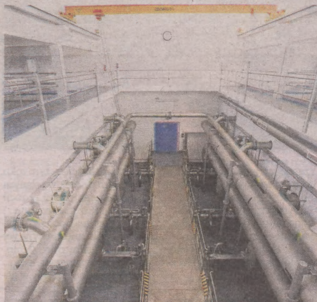
Woda jest napowietrzana - dodawany tlen wytrąca żelazo i mangan
