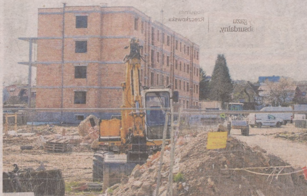
Budowa osiedla przy ul. Szczecińskiej
