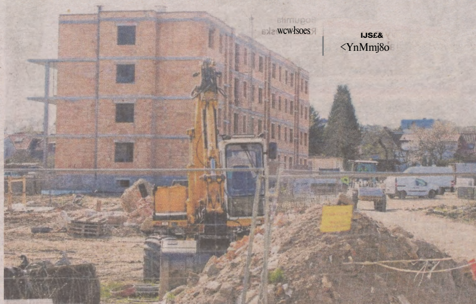
Budowa osiedla przy ul. Szczecińskiej
