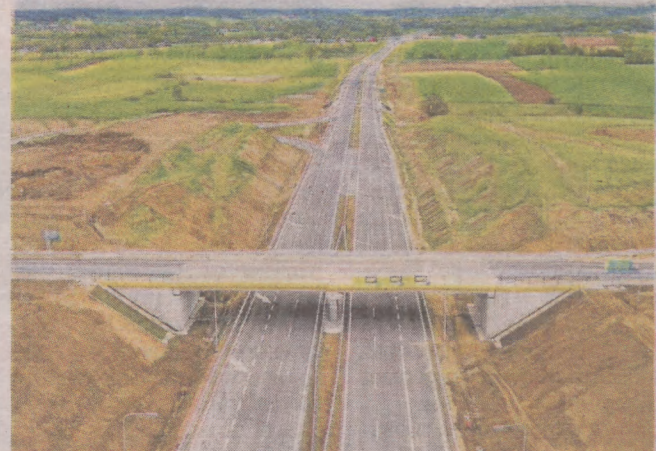
Prace budowlane na trasie S6
