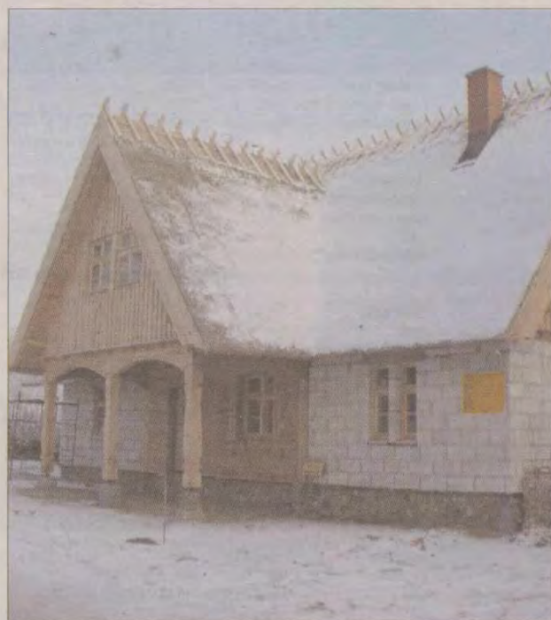
Już wkrótce zostanie zakończona budowa Muzeum Kaszubskiego w Brusach Jagliach.
