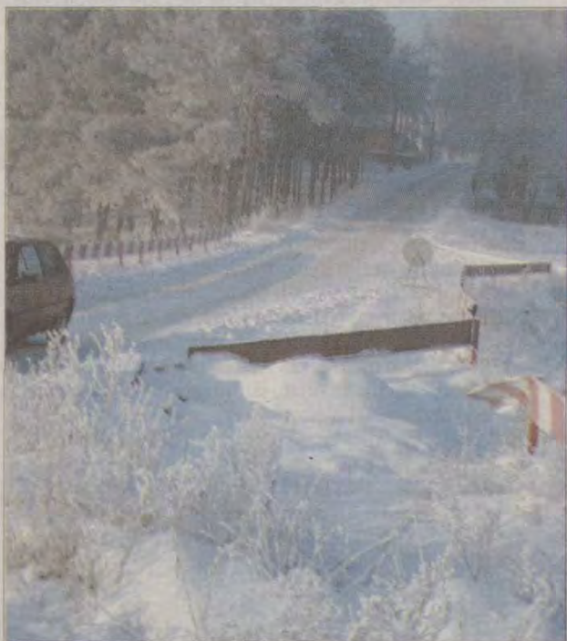
W tym roku zostanie naprawiony mostek, który zawalił się latem 2002 roku. Fot. Maria Sowisło/archiwum
