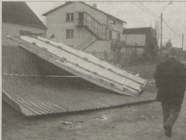
Dach jednego z budynków przy ul. Sienkiewicza w Człuchowie został przeniesiony przez wiatr na drugą stronę ulicy.
