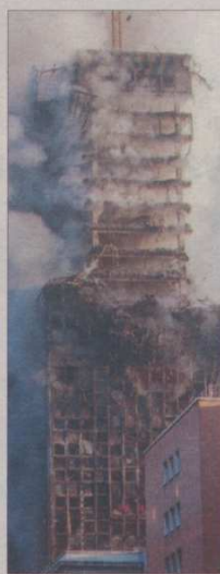
Zniszczony wieżowiec grozi zawaleniem.
