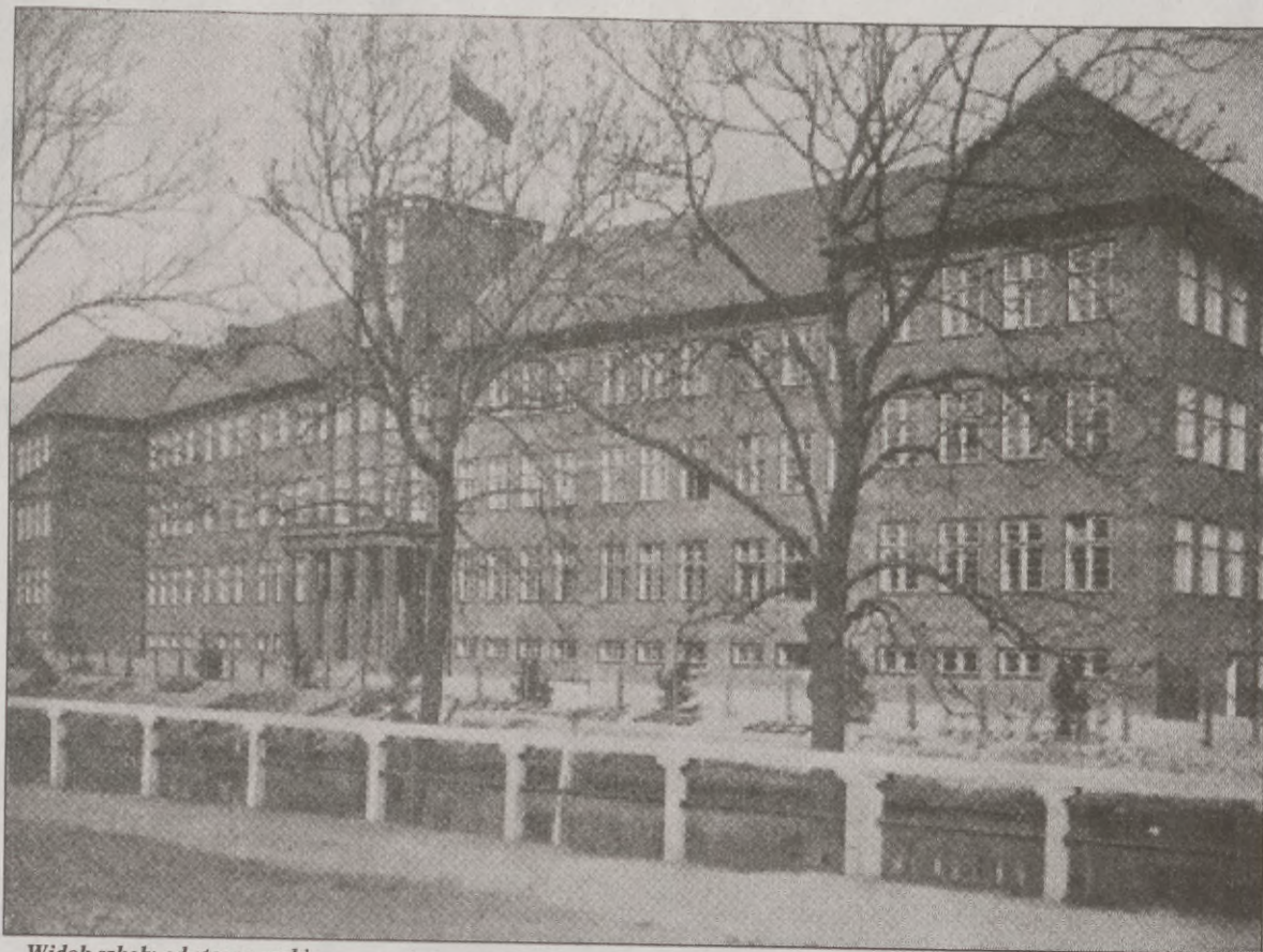
Widok szkoły od strony rzeki
