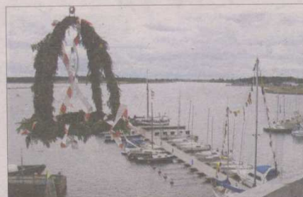
Wczoraj zawieszono wiechę na budynku Narodowego Centrum Żeglarstwa Akademii Wychowania Fizycznego i Sportu w Gdańsku Górkach Zachodnich.
