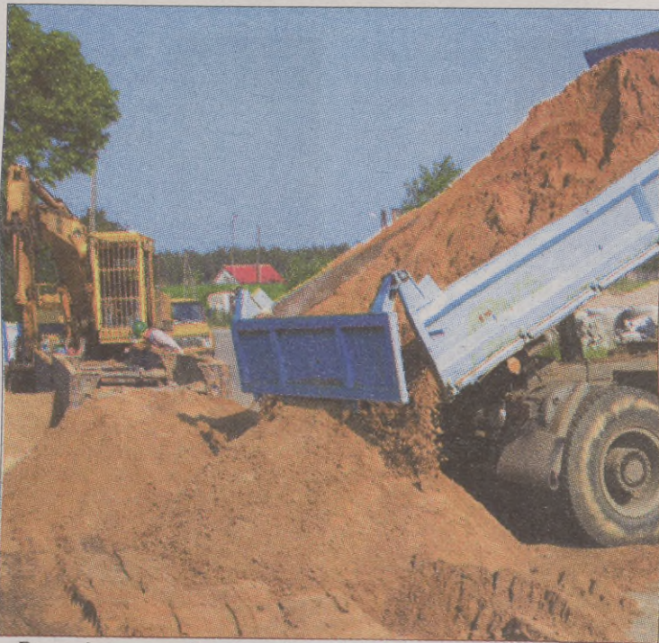
Prace ziemne na ul. Jeziornej są już prawie na ukończeniu
