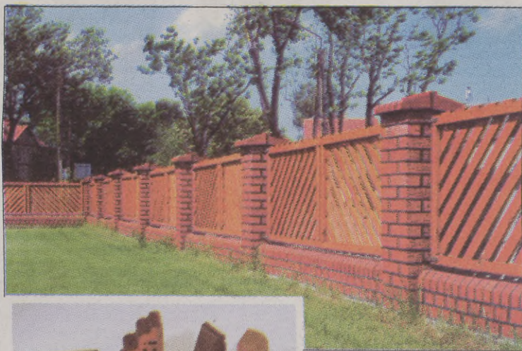
▲ Ogrodzenie wykonane z zastosowaniem cegieł kształtowych
