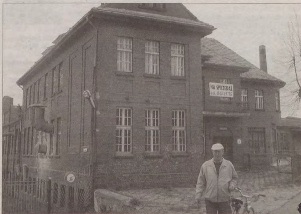
Niewykluczone, że już niebawem te budynki zostaną wyburzone.
