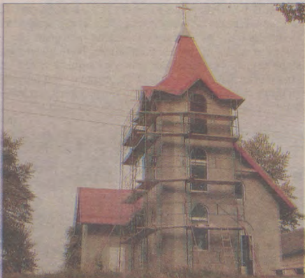
Kościół wybudowali sami mieszkańcy. Teraz trwają jeszcze prace przy elewacji, ale już niedługo wszystko będzie gotowe.
