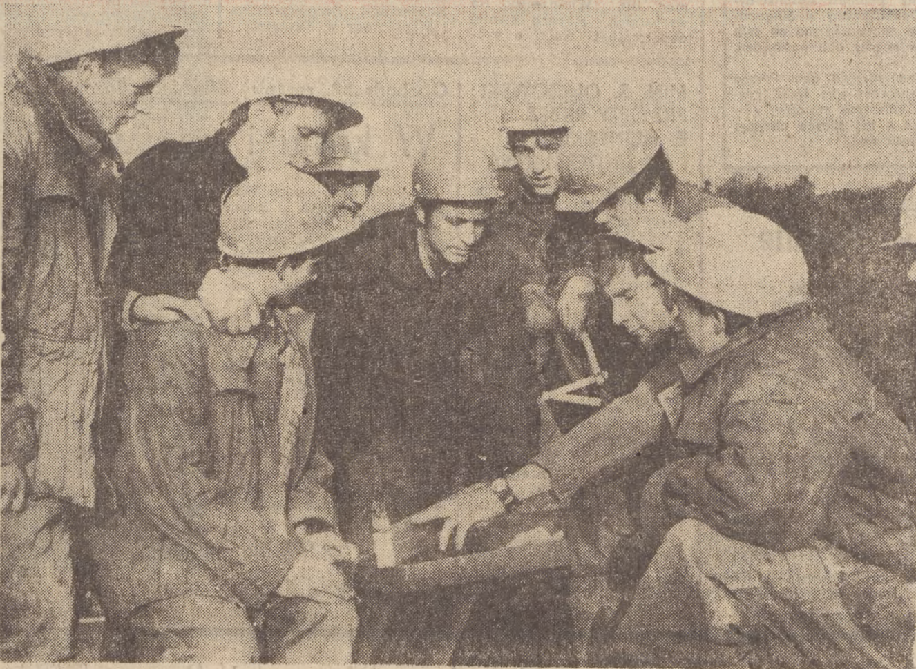
Na zdjęciu: czyn zjazdowy realizuje m. In. grupa ciesielska Junaków OHP pod kierunkiem Instruktora Boleśława Boruca. Junacy zobowiązali się do 15 listopada br. wykonać zaplecze socjalne dla budowy przychodni specjalistycznej w Koszalinie oraz niezbędne roboty ciesielskie. Wartość czynu wynosi 300 tys. zł.
