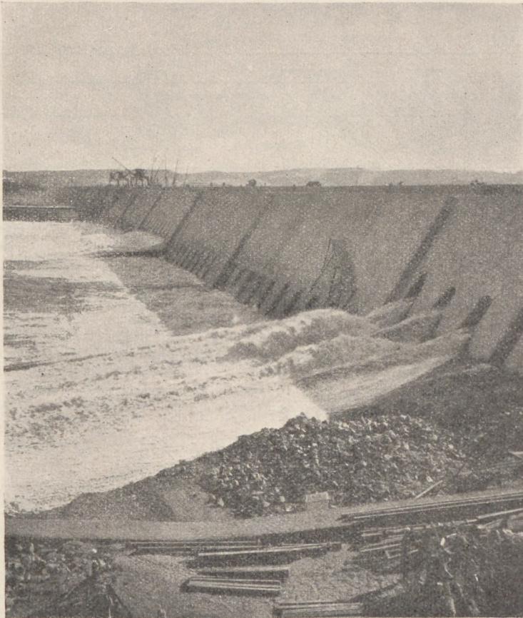
Abb. 15. Der westliche Teil des Assuandammes nach ausgeführter Verstärkung im Dezember 1908.
