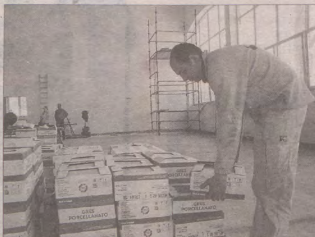
Prace, jakie prowadzono w placówce były gruntowe...
