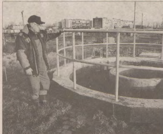
Główna inwestycja na ten rok to budowa nowej sieci kanalizacyjnej w Majewie.
