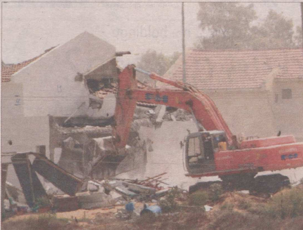
Buldożery burzą budynki opuszczone przez osadników.
