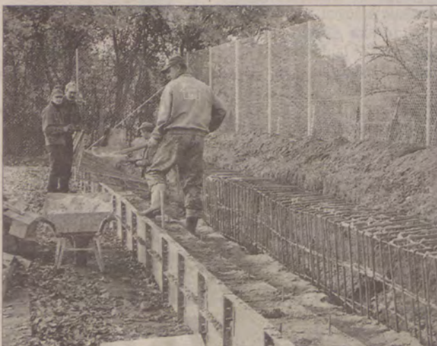
W IV edycji Pomorskiego Programu Odnowy Wsi w ramach Kontraktu Wojewódzkiego na 2004 r. gmina Tczew pozyskała środki finansowe na kontynuację zadania pn. „Budowa boiska sportowego w Miłobądku - I etap - wykonanie ławek dla publiczności i ogrodzenia”.
