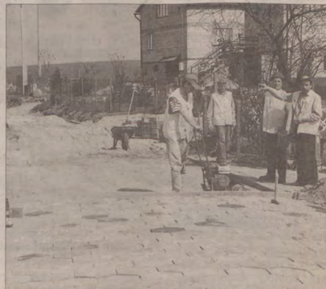
Każdego roku w gm. Tczew prowadzone są większe i mniejsze remonty dróg. Na zdj. remont drogi z Gniszewa w kierunku Śliwin.
