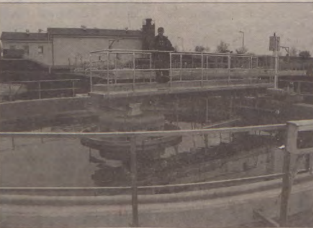
Największą inwestycją jest oddana 2 sierpnia do użytku nowoczesna oczyszczalnia ścieków.
