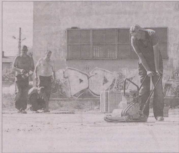
Płyta przyszłego skate parku jest gotowa. Jej budowa trwała kilka tygodni.
