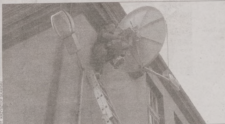
Montaż systemu na budynku starostwa
