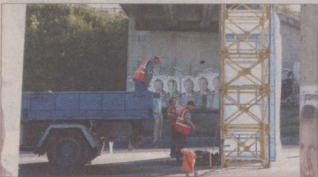
Pracownicy firmy Polwar już od dwóch dni naprawiają wiadukt. Do końca października ma on być gotowy.
