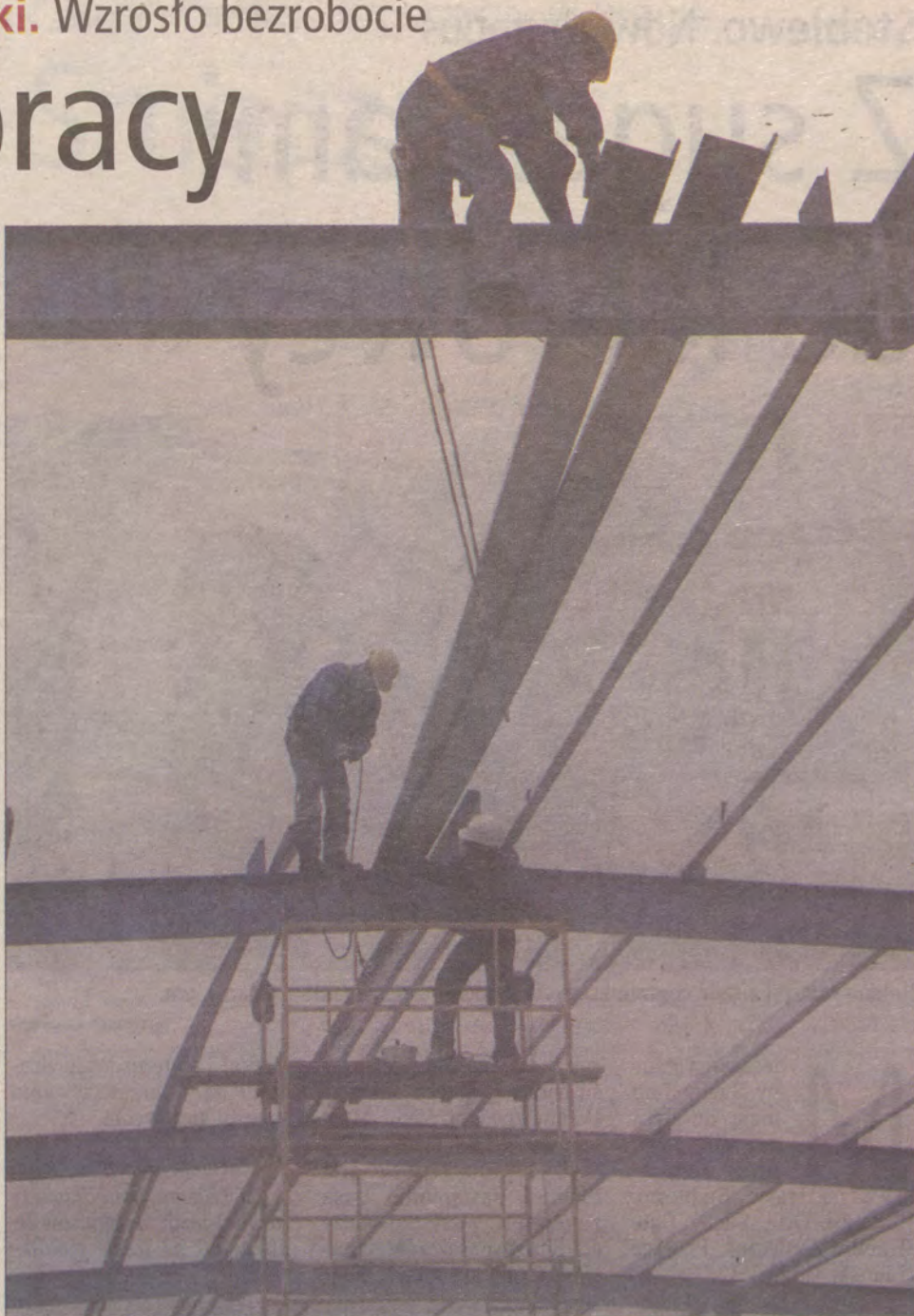
Magazyn firmy budowlanej rośnie jak na drożdżach. Pracę ma tu znaleźć siedem osób.
