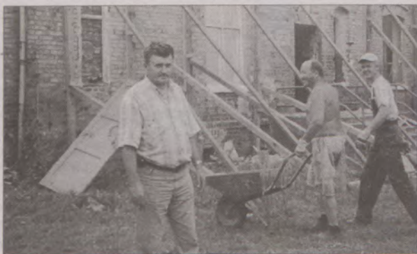
- Prace przebiegają powoli, bo są niebezpieczne - tłumaczy Wojciech Skibiński (z lewej).
