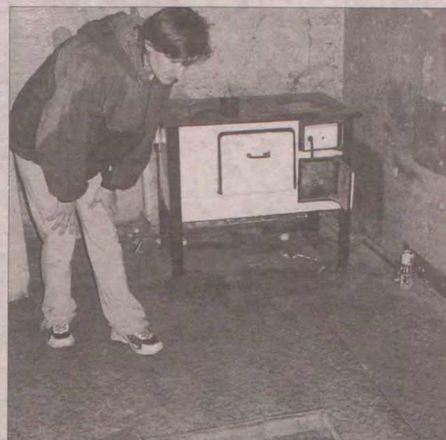
- W takich warunkach nie można żyć. Budynek wymaga kapitalnego remontu - mówi Agnieszka Kleist.
