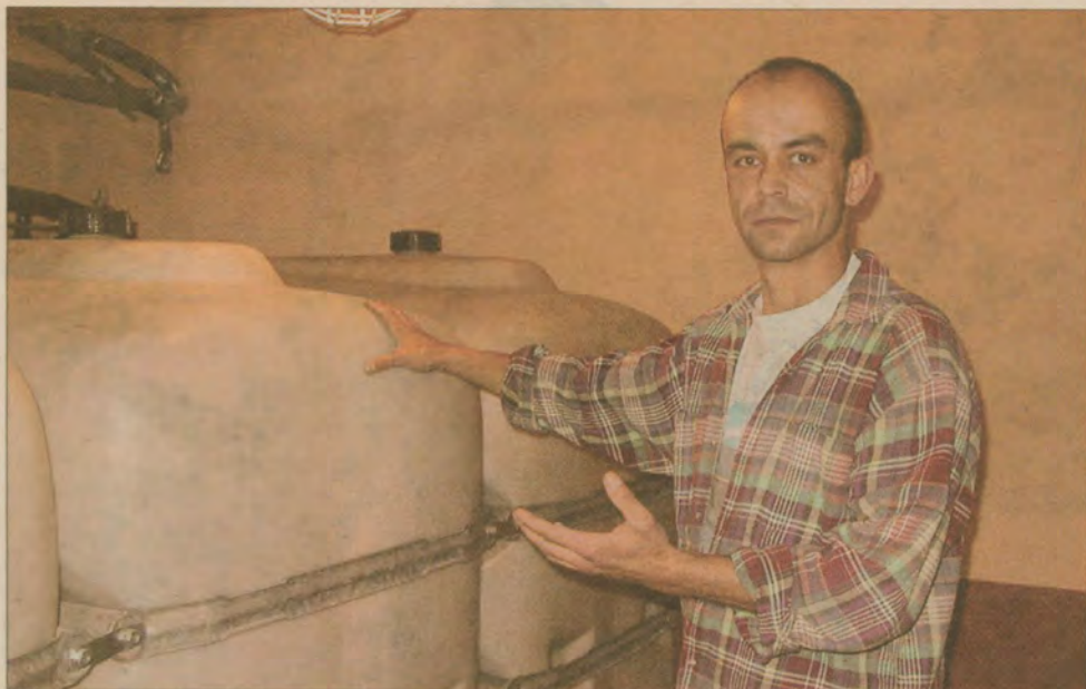
Piotr Szumigała obsługuje piec centralnego ogrzewania w Szkole Podstawowej nr 3 w Pruszczu Gdańskim. W czasie dużych mrozów zbiornik oleju opałowego o pojemności 3 tysięcy litrów wystarcza na trzy dni. Po wprowadzeniu podwyżki akcyzy jego napełnienie byłoby droższe o ok. 2,5 tys. zł.
