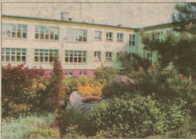
Tak wygląda teraz wewnętrzne, zielone, ukwiecone patio szkoły.
