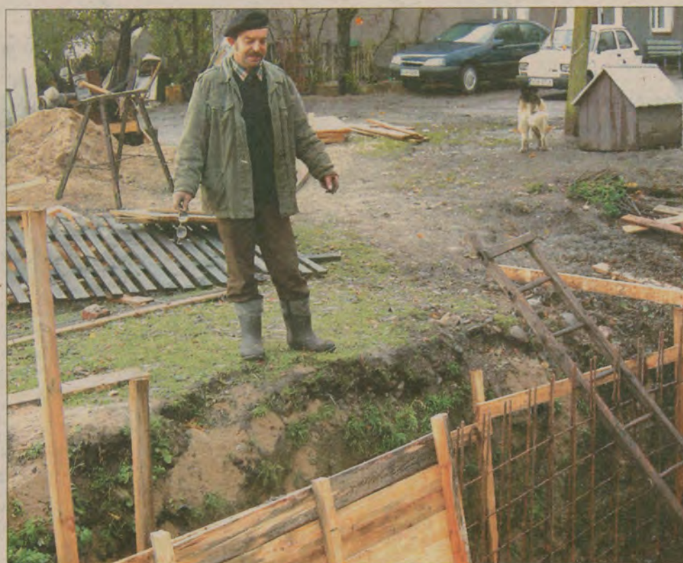
Czesław Wlazło pokazuje wodę stojącą w wykopie, który ma być gnojownikiem.
