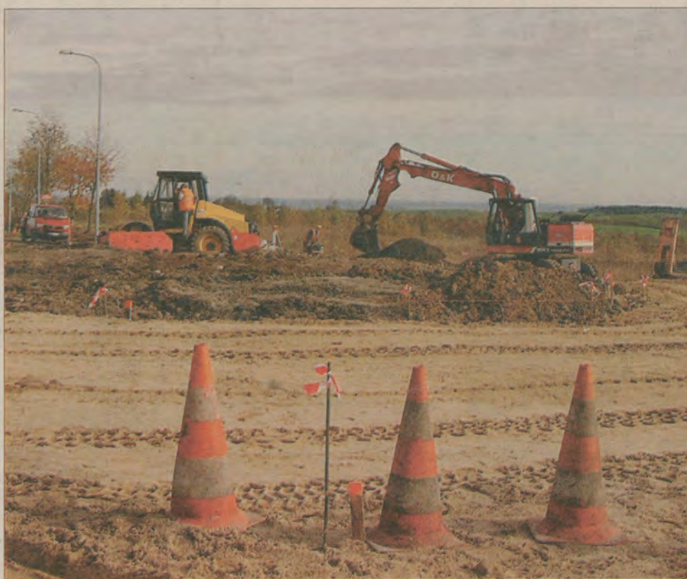
(GANARK) Trwa budowa ronda w Jagatowie.
