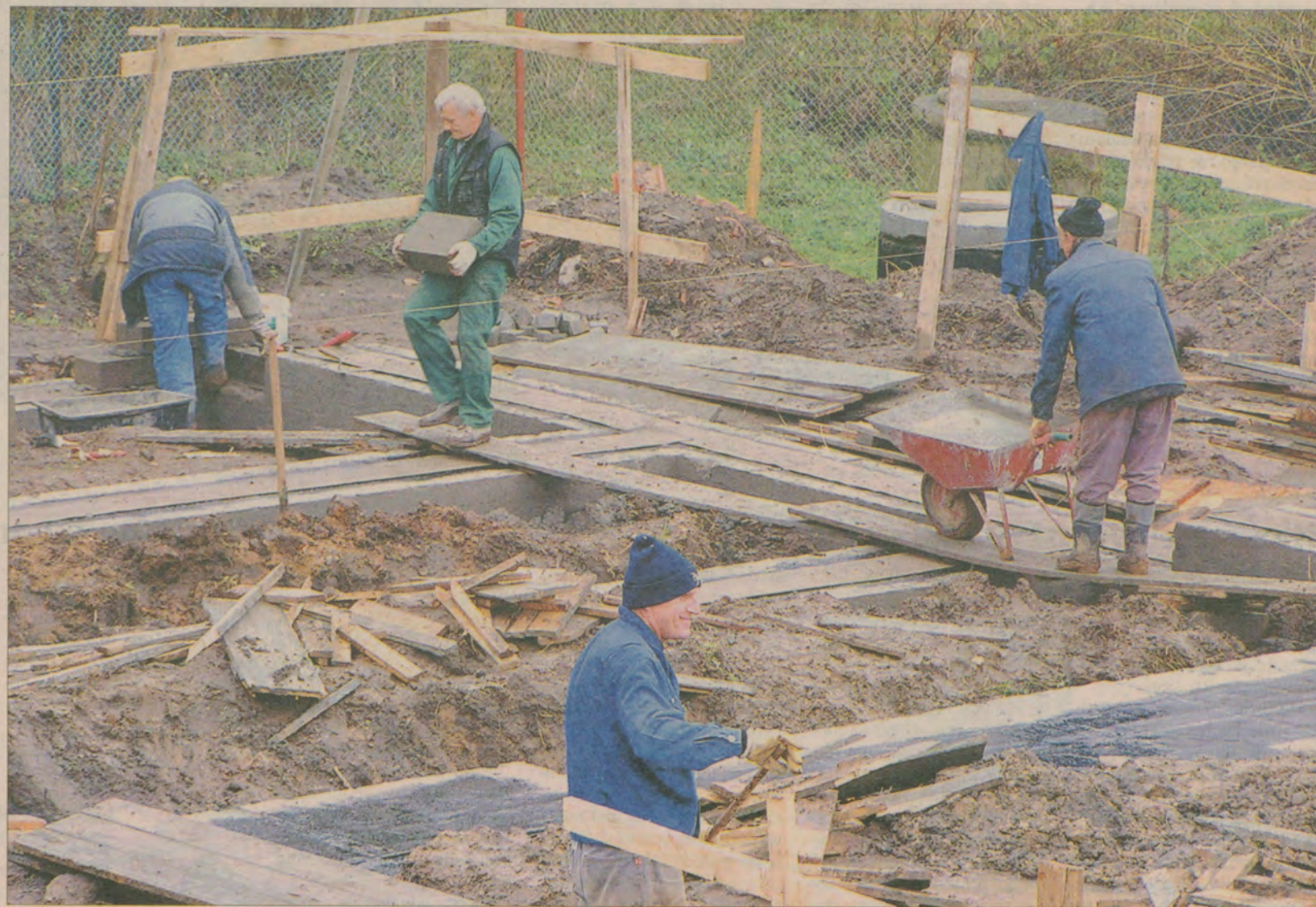
Rozpoczęła się budowa 12-rodzinnego bloku komunalnego w Rusocinie. Lokatorzy będą się mogli wprowadzić wiosną 2007 roku.
