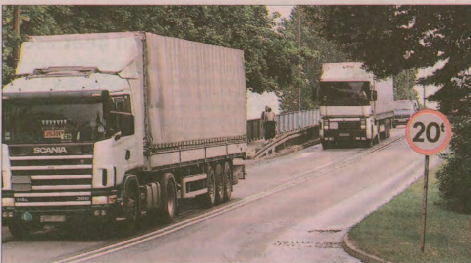
Od lipca kontrolowany będzie ciężar tirów przejeżdżających przez wiadukt w Pruszcze.
