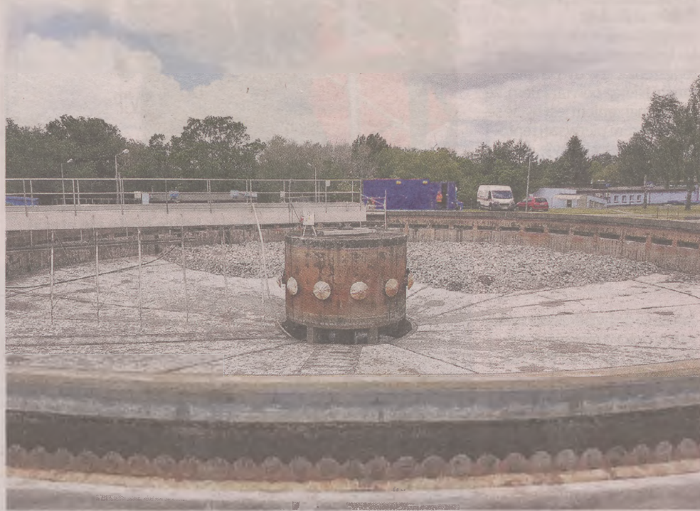
Modernizacja zbiornika retencyjno-przelewowego na OŚ w Słupsku
