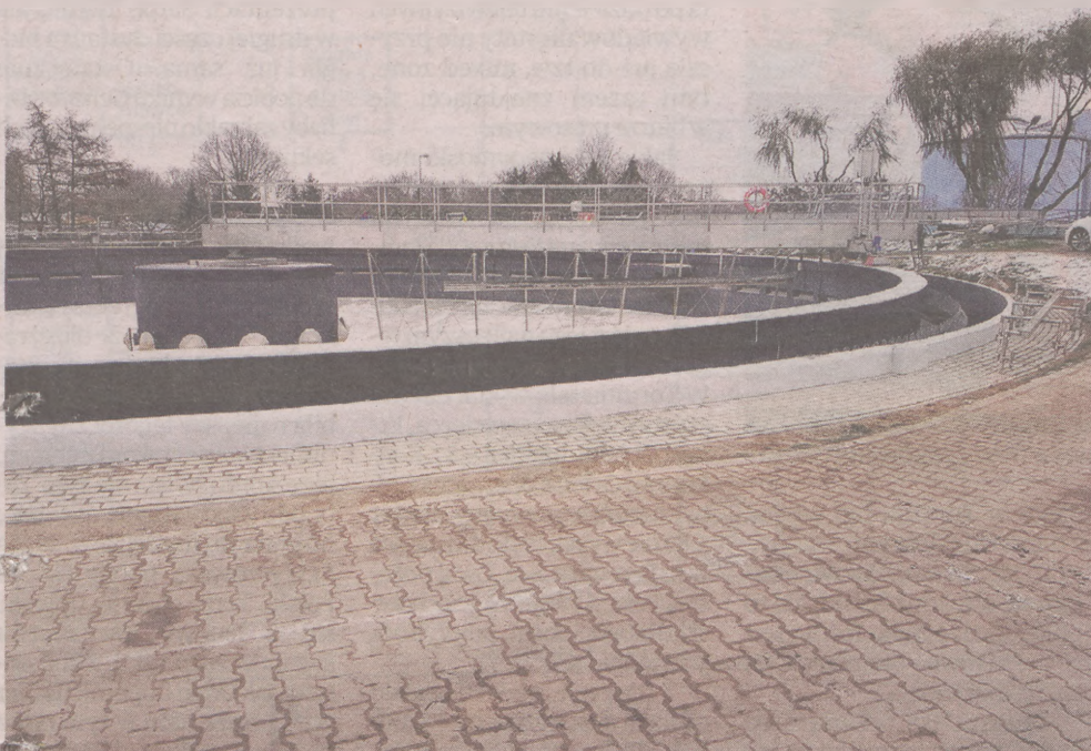
Modernizacja zbiornika retencyjno-przelewowego na OŚ w Słupsku
