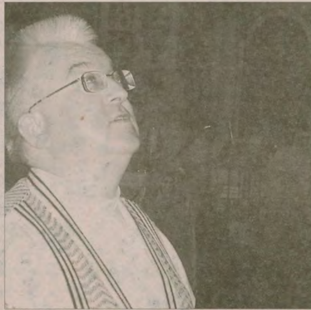
- Boazeria z desek przez ponad pół wieku szpeciła kościół w Pręgowie - mówi ks. proboszcz Zygmunt Słomski, wpadając się strop świątyni.
