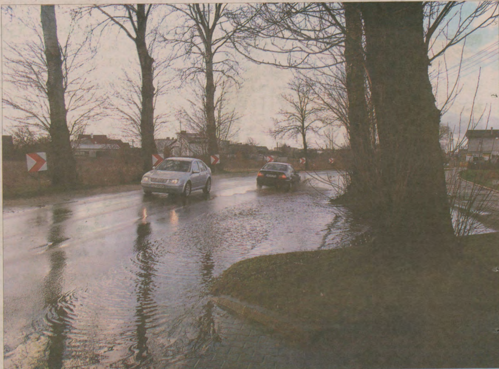
Ulica Kopernika, jak widać, wymagała remontu.
