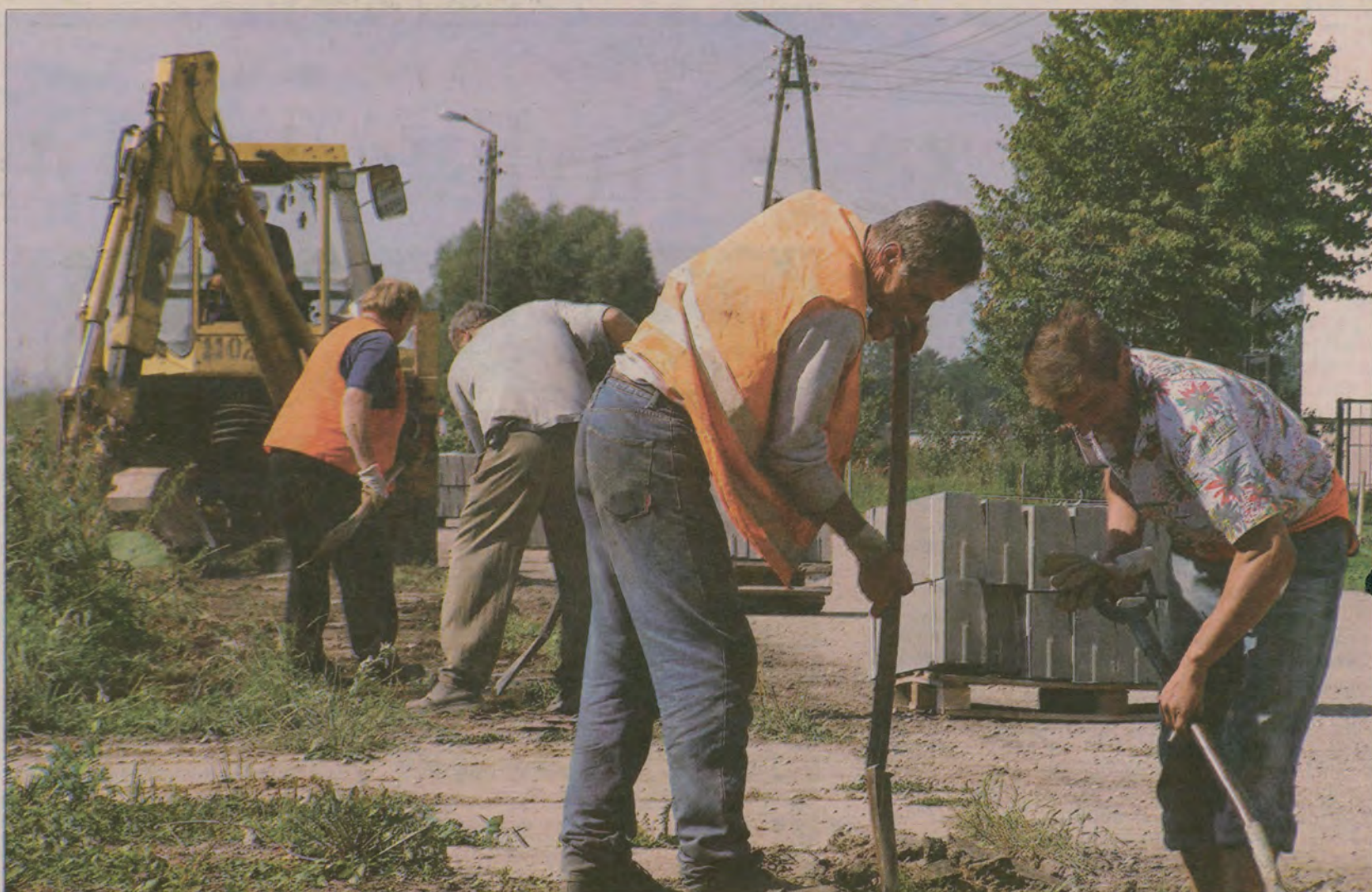
Budowa chodnika w Suchym Dębie. W tym roku, taka sama inwestycja będzie prowadzona na nowych zasadach.
