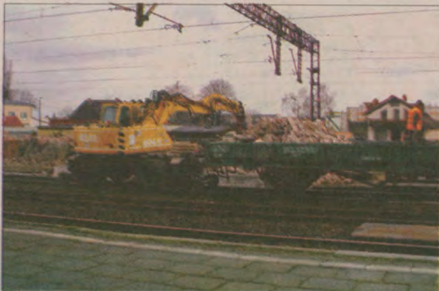
Ekipa rozbiórkowa błyskawicznie uporała się z niewielkim budynkiem na peronie, gdzie przed laty dyżurowali zawiadowcy.
