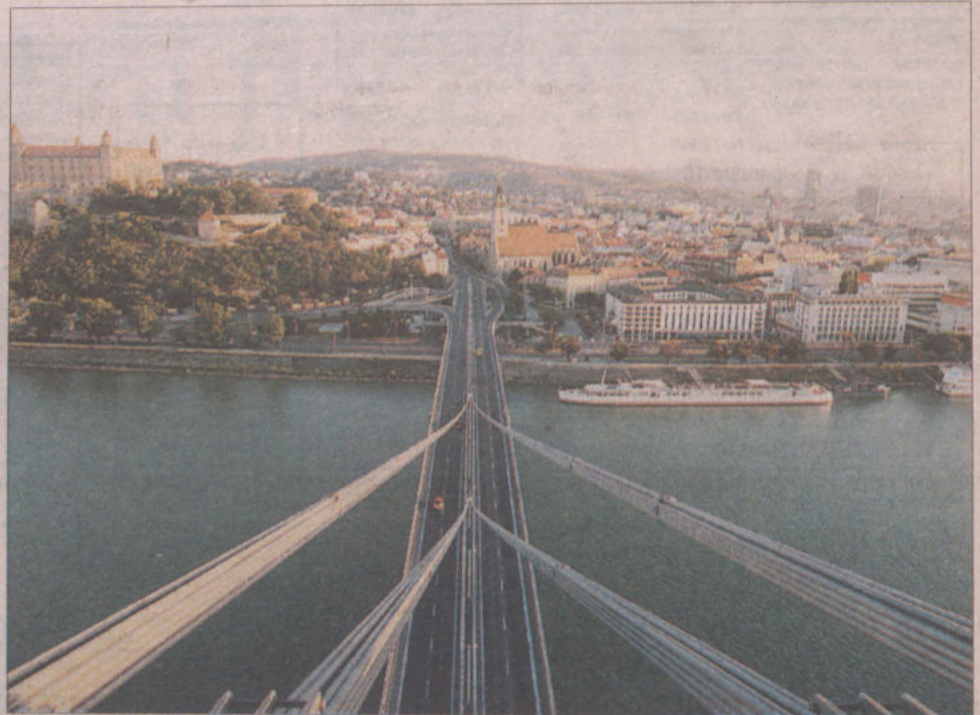
Z restauracji umieszczonej na szczycie przęsła Nowego Mostu widać panoramę miasta.
