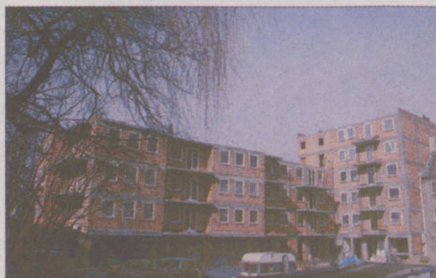
Ładowy statek w budowie - od strony przyszłego dziedzińca skrzydło wewnętrzne.
