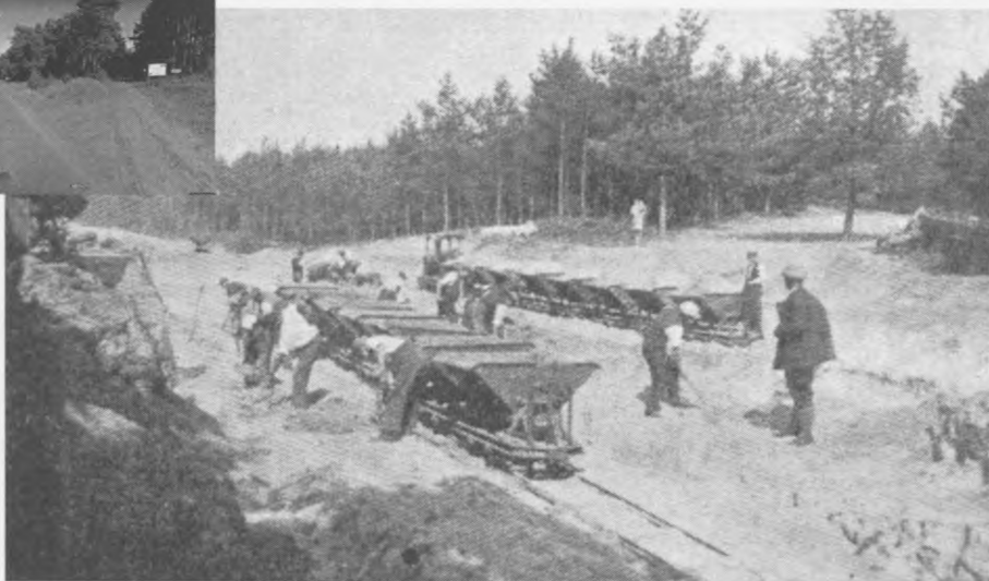
Zdjęcie z 1933 r. Prace przy budowie drogi. W lewym górnym rogu stan obecny, fot. Heimatkalender... 1933
