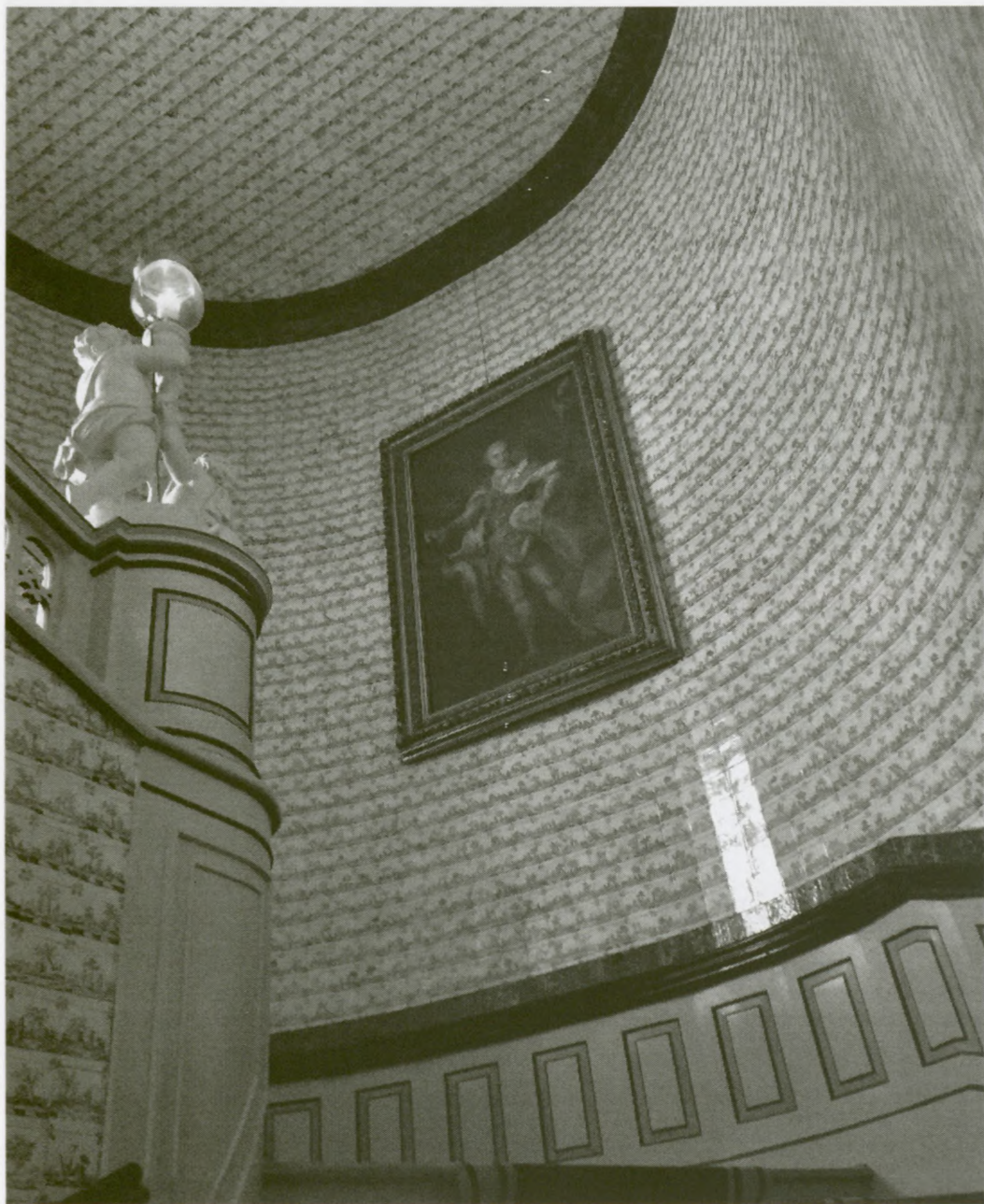
Pałac w Nieborowie, olicowanie ścian i sufitu klatki schodowej, fot. B. Grudziecka
